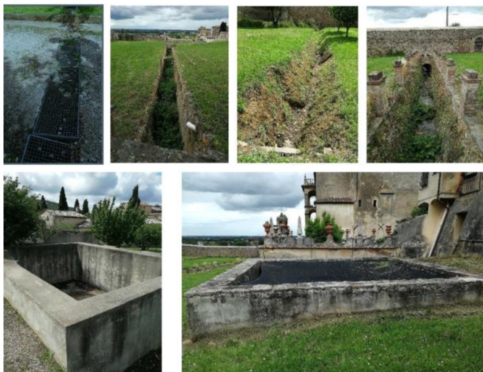
Fig.4: Sistema di gestione acque meteoriche
