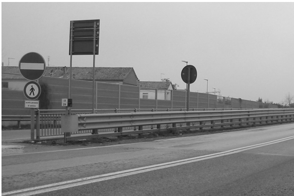
Figura 7 – barriera antirumore all'ingresso di un centro urbano
