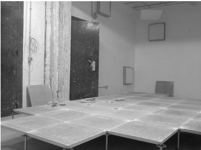
Figura 3: Fasi del montaggio del campione sottoposto a prova.
