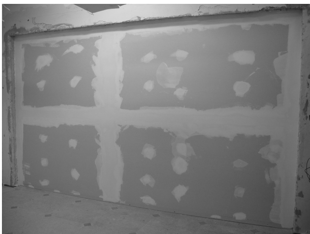
Figura 6: Vista della parete divisoria posta tra i due ambienti di prova.
