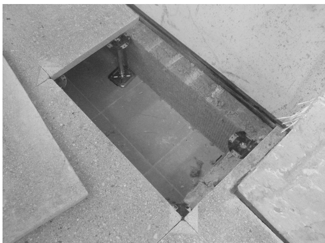
Figura 5: Particolare del materiale fonoassorbente installato lungo le pareti dell'intercapedine.
