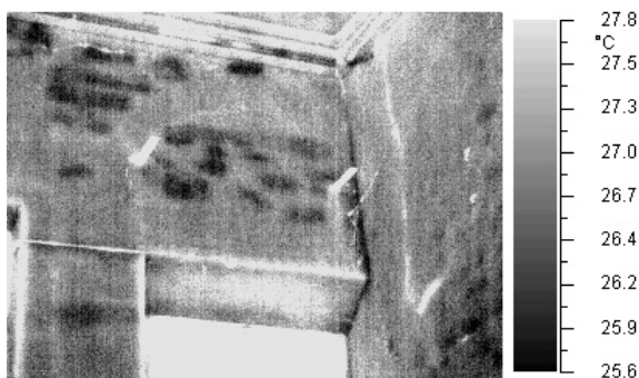
Fig. 1. Esempio di immagine termografica di parete interna.
